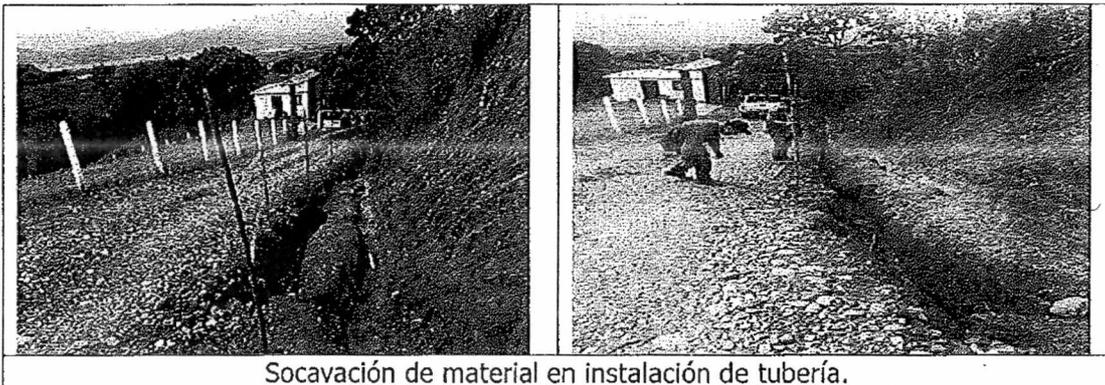
Socavación de material en instalación de tubería.
